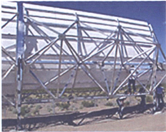
图5 SGX-1 聚光器结构
