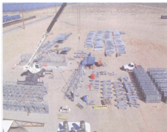
图3 EUROTROUGH 聚光器组装现场
